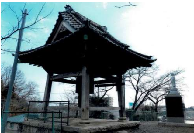
昭和23年に移築された鐘楼
