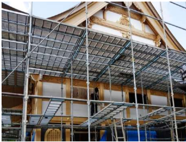
建設中の本堂
